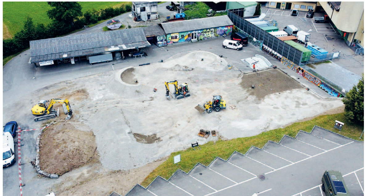
Auf dem Holflüe-Areal entsteht der neue Pumptrack mit Spielplatz und Mietstation (Stand Juli 2024).
